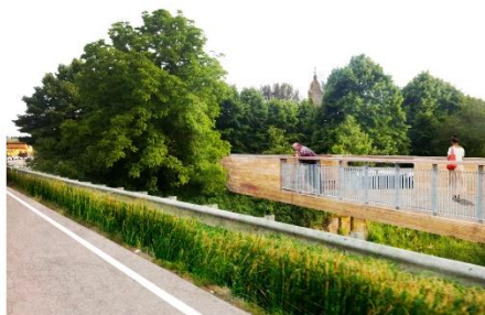
2 Ponte ciclopedonale sull'Ombrone utilizzabile come ponte carrabile temporaneo nel corso dei lavori di riqualificazione del ponte della Cassia
